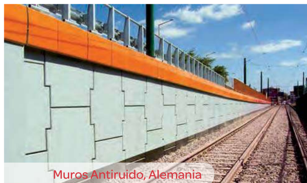
Estribo de Puente en Línea Férrea
