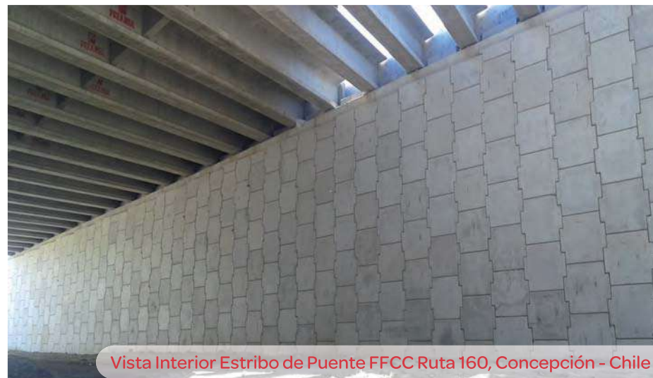
Estribo de Puente FFCC Ruta 160, Concepción - Chile
